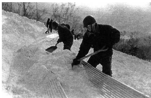
浪板の樋を利用した雪の輸送
